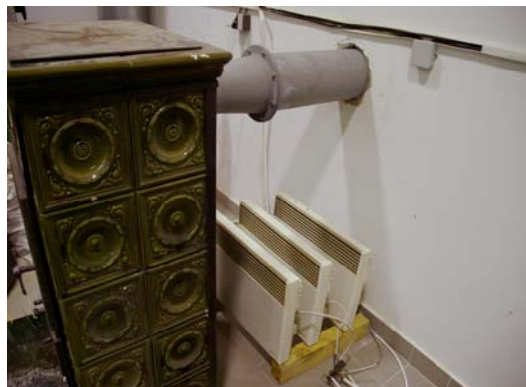
Obr. 7: Průchod kouřovodu zdí směrem k filtru
